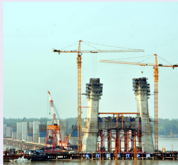
主塔塔柱施工
