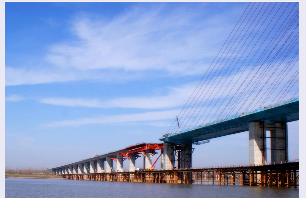
引桥移动模架施工
