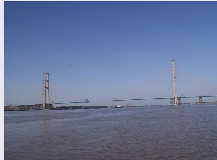
主桥上部结构施工
