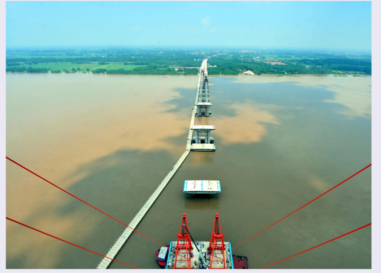
北塔钢箱梁吊装俯瞰图
