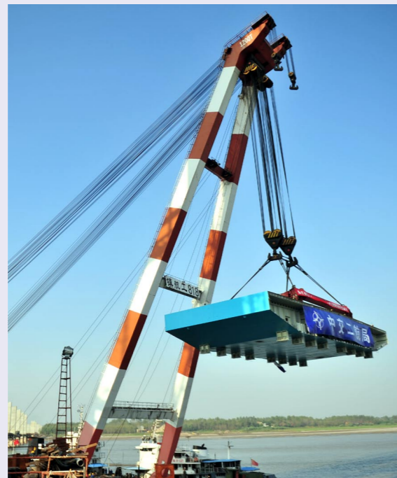
钢箱梁存梁吊装
