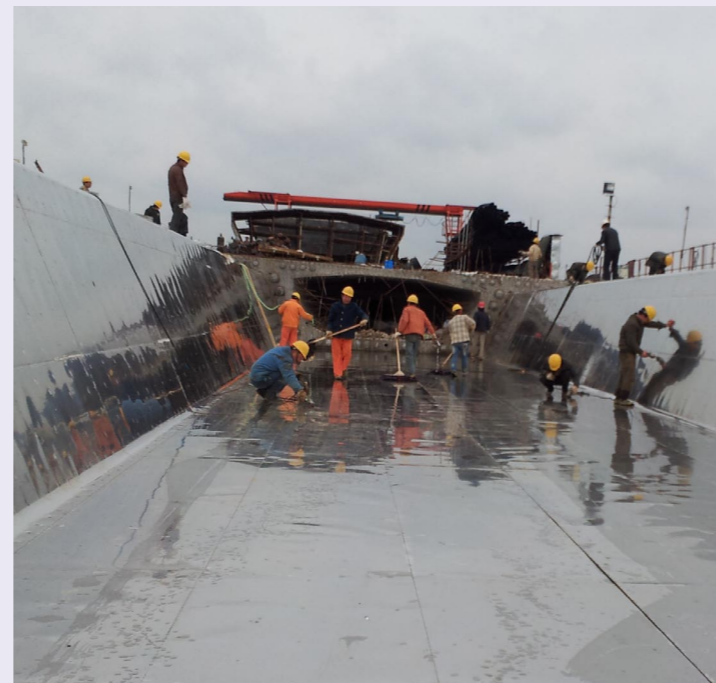
引桥箱梁外模不锈钢施工
