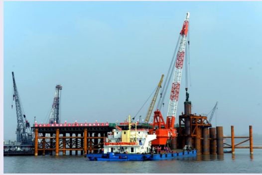
主塔基础施工平台搭设
