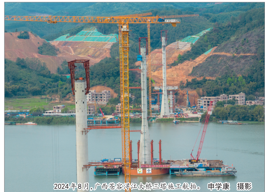
2024年8月，广西苍容浔江大桥三塔塔基航拍。申学康 摄影
